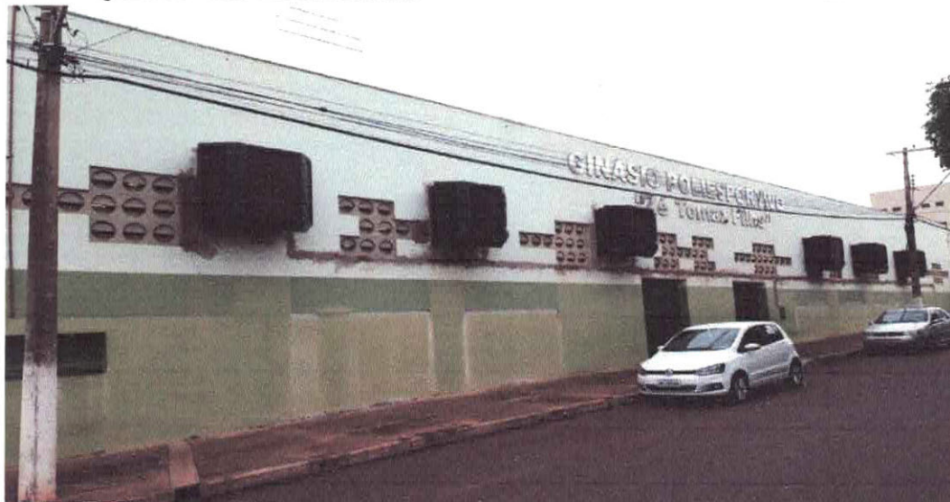
Ginásio Poliesportivo – Zé Tomaz Freitas
