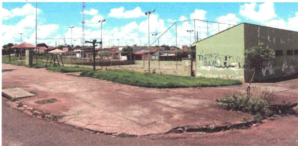
Quadra municipal do Bairro Antônio Bráulio
