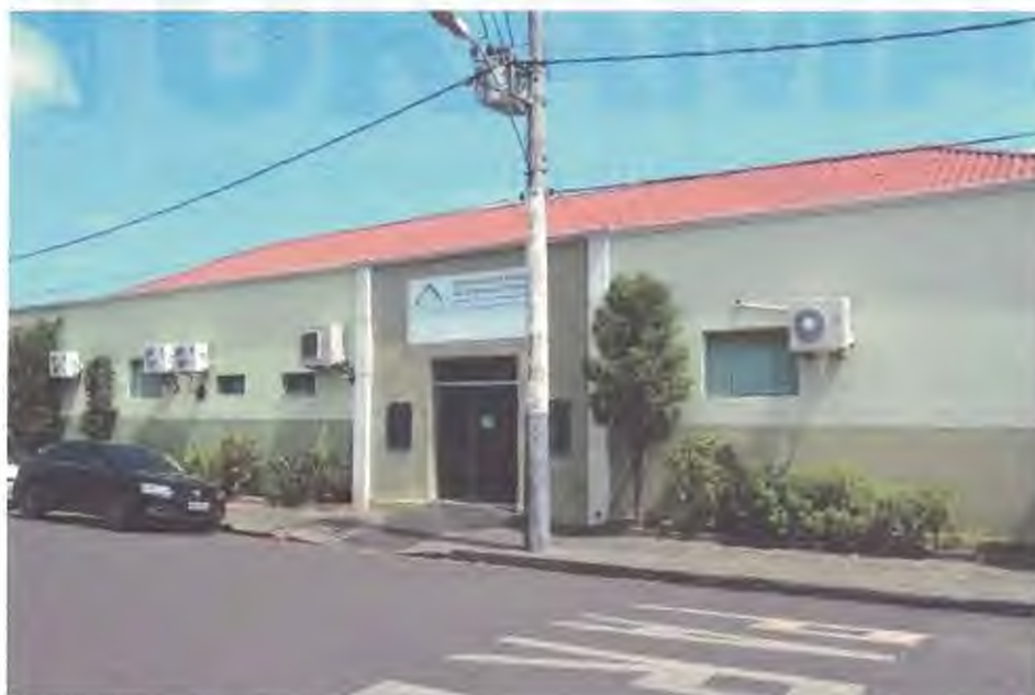
Prédio UFTM Iturama
